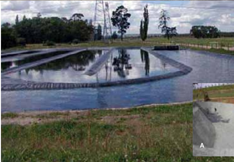
Figura 11 - Vasche “raceway” per il trattamento di acque reflue
