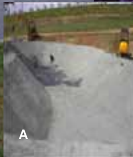
Figura 11 - Vasche “raceway” per il trattamento di acque reflue
